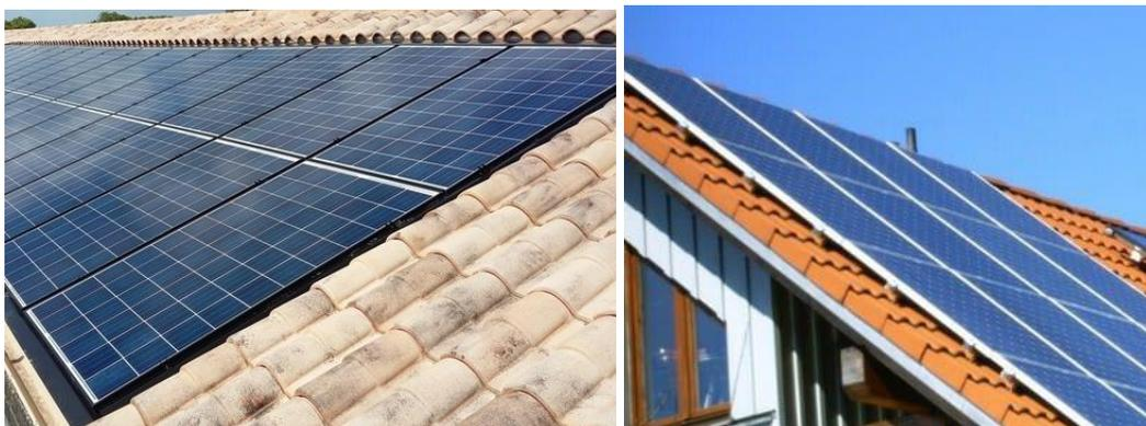
Exemple de panneaux solaires intégrés dans la pente de la toiture
